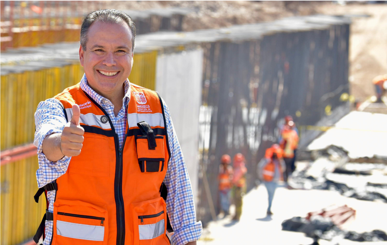
Supervisión de obra Paso a Desnivel Colosio y Solidaridad.
